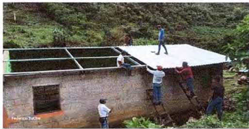
Foto1: LAS COSTANERAS YA CAMBIADA EN METAL E INSTALANDO LAS LAMINAS.
