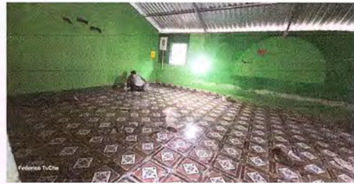
Foto 2: EL PISO CONVERTIDO EN PISO CERAMICA.
