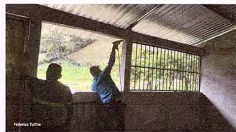
Foto 6: LOS HERREROS ESTAN TERMINANDO EL TRABAJO PARA LA COCINA.
