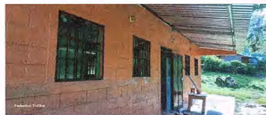
Foto 3: INSTALANDO BALCONES DE VENTANAS.
