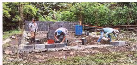
Foto 4: INICIO DE CONSTRUCCION DE COCINA.
