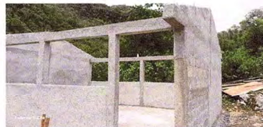
Foto 5: LA COCINA YA ESTA LEVANTADA FALTA EL TECHADO.
